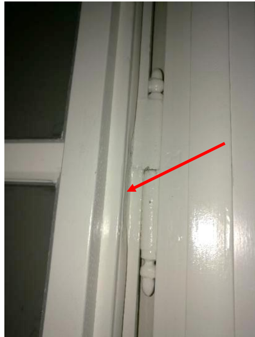
Abbildung 13: Frisch saniertes Fenster. Bei diesem Fensterflügel ist nicht genügend Raum auf der Bandseite vorhanden. Beim Schliessen des Flügels entstehen aufgrund der Hebel unkontrollierte Kräfte. Diese führen zur Beschädigung der Hohlkammerdichtung sowie des Fensters.
