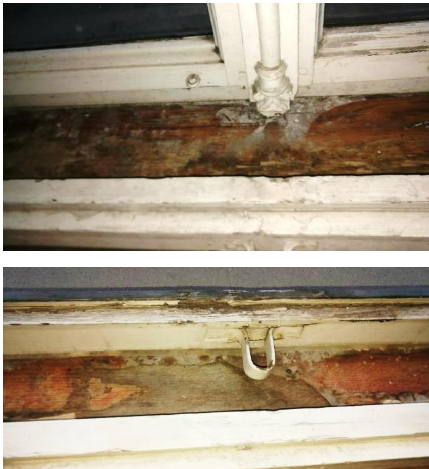
Abbildung 11: Typische Schadensbilder wetterseitig aufgrund von Wassereintritt bei Schlagregen
