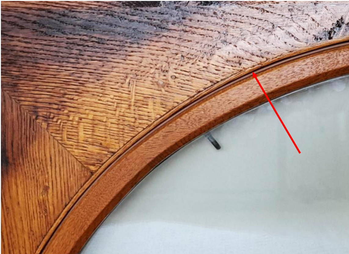
Abbildung 15: Von aussen einsehbare und somit überprüfbare Lage der Dichtung im exakt hergestellten Dichtungsspalt zwischen bestehendem Festrahmen und neuem Doppel auf dem Fensterflügel.
