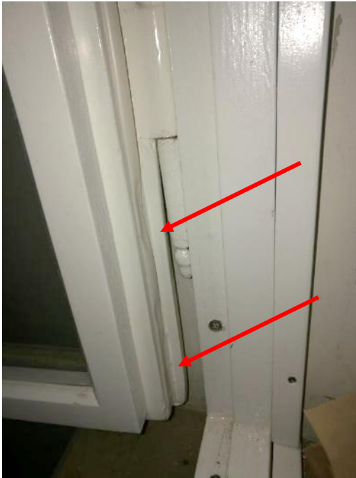
Abbildung 13: Frisch saniertes Fenster. Bei diesem Fensterflügel ist nicht genügend Raum auf der Bandseite vorhanden. Beim Schliessen des Flügels entstehen aufgrund der Hebel unkontrollierte Kräfte. Diese führen zur Beschädigung der Hohlkammerdichtung sowie des Fensters.
