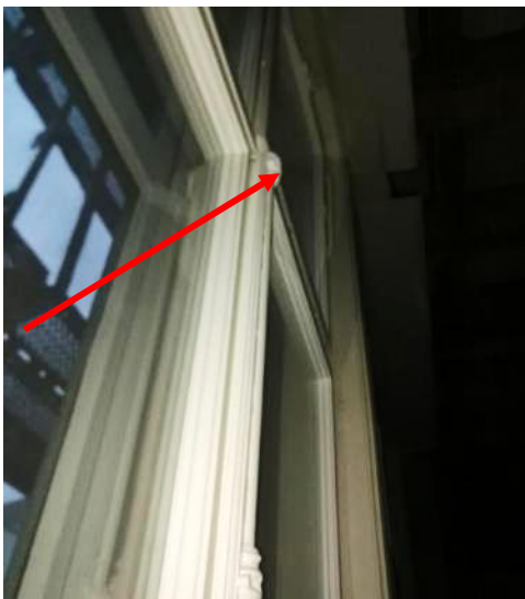
Abbildung 14: Bei diesem Fenster fehlt es auf der Seite des Verschlusses an Platz für die Dichtung. Die Konsequenz: Das Fenster lässt sich nur mit Mühe schliessen, indem deutlich über dem Fenstergriff das Fenster zgedrückt wird, so dass oben die Stange in die Fangklobe einfahren kann.
