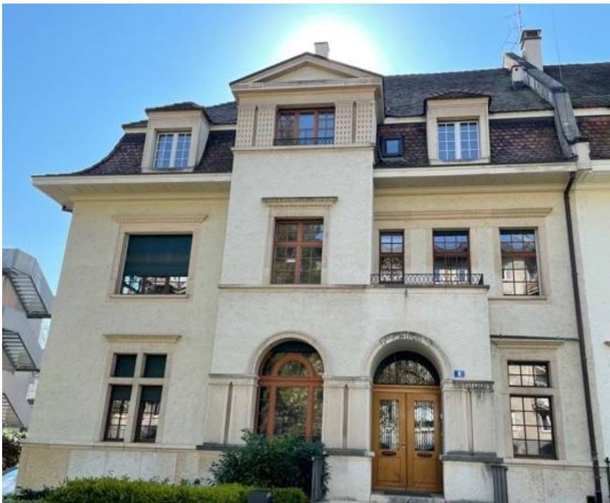
Abbildung 7: Bereits zweimal renoviert: Haus von Swisslos an der Lange Gasse 8 in Basel
