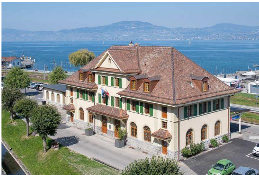
Abbildung 1: Historisches Bahnhofsgebäude (1926): Das heute als Stadtverwaltung, Tourismusbüro und Mehrzweckhalle genutzte Gebäude wurde 2019 mit dem «Roten Nagel» des Schweizer Heimatschutzes ausgezeichnet. Quadra Ligna renovierte die Fenster im Erdgeschoss und 1. Stock.
