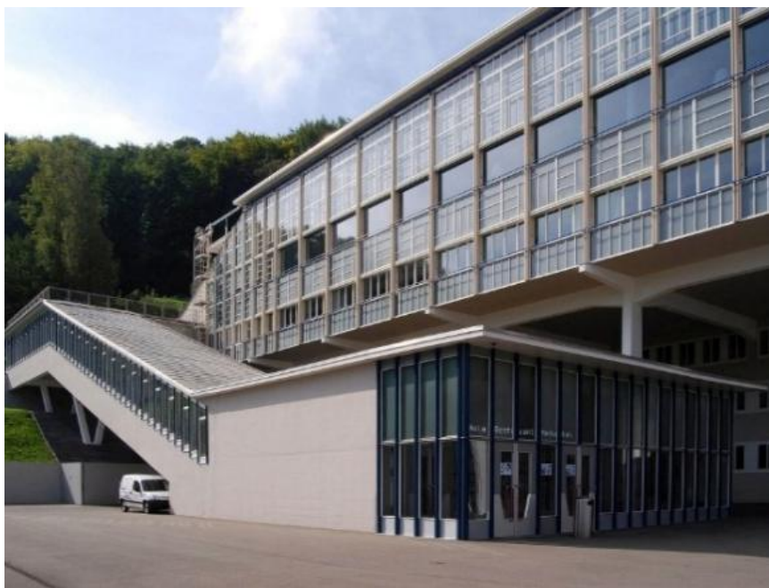
Abbildung 4: Ehemaliges BBC-Gemeinschaftsgebäude in Baden (1952–53, Architekt Armin Meili): Das denkmalgeschützte Bauwerk gilt als bedeutender Vertreter der Schweizer Nachkriegsmoderne. Quadra Ligna renovierte 2016 die Fenster im Treppenaufgang und weiteren Bereichen.
